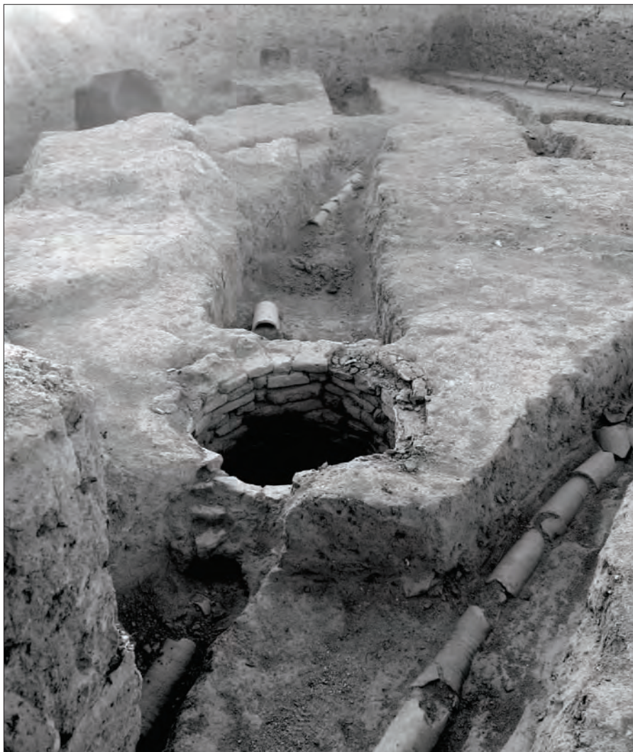
Рис. 107. Сливная труба и водопоглощающий колодец
